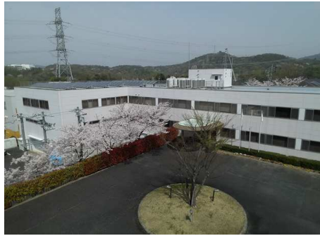
中部電気保安協会 人財・技術開発センター（ドローン撮影）
